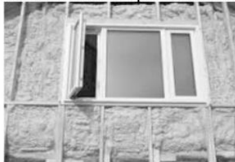
Isolation des murs par l'extérieur
