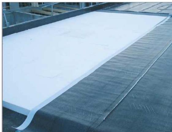
Exemple de pose directe sur le Knauf Therm TTI Th36 SE de la 1<sup>re</sup> couche d'étanchéité à joints adhésifs.
